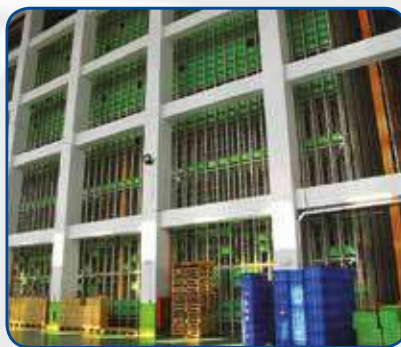
Magazzino Automatizzato High capacity warehousing
