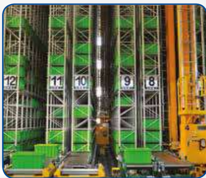
Magazzino Automatizzato Automated warehousing
